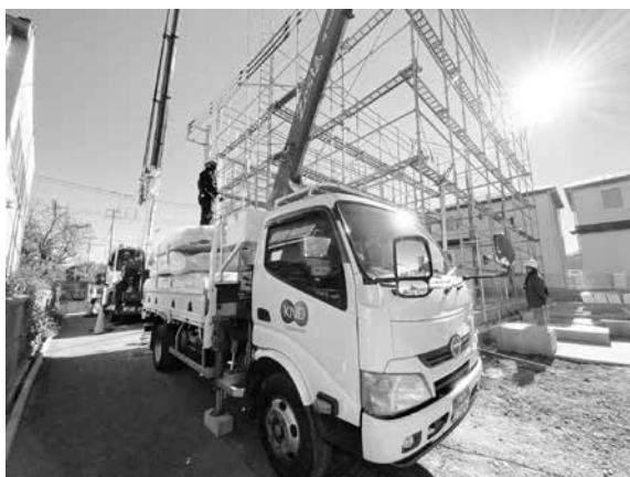
図2 現場下ろし作業風景
