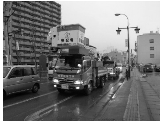
電力、電話などのインフラは全国から応援が集結、直ちに復旧に取り掛かった(石巻市・2011年3月24日)
