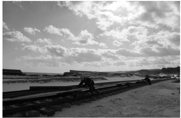
人力で新しいレールを移動させる三陸鉄道北リアス線の復旧作業
