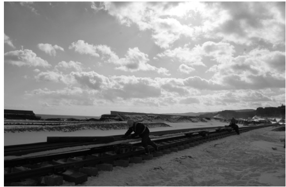
人力で新しいレールを移動させる三陸鉄道北リアス線の復旧作業
